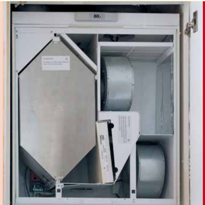
Lüftungsgerät mit Wärmerückgewinnung
