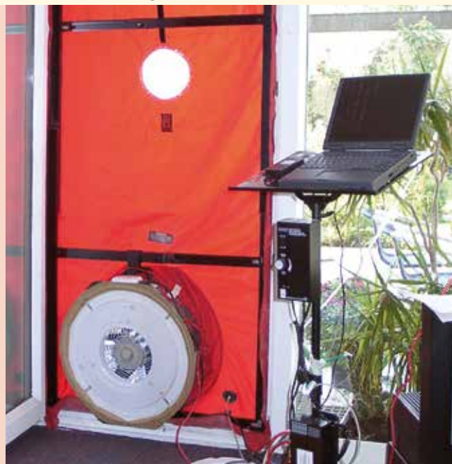
Ventilator zur Durchführung eines Drucktests
