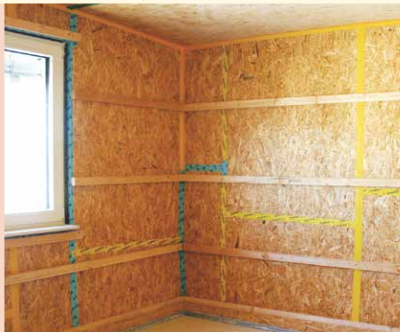
Luftdicht verbundene Holzwerkstoffplatten
