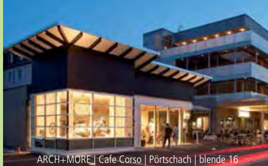
ARCH+MORE | Cafe Corso | Pörtschach | blende 16
